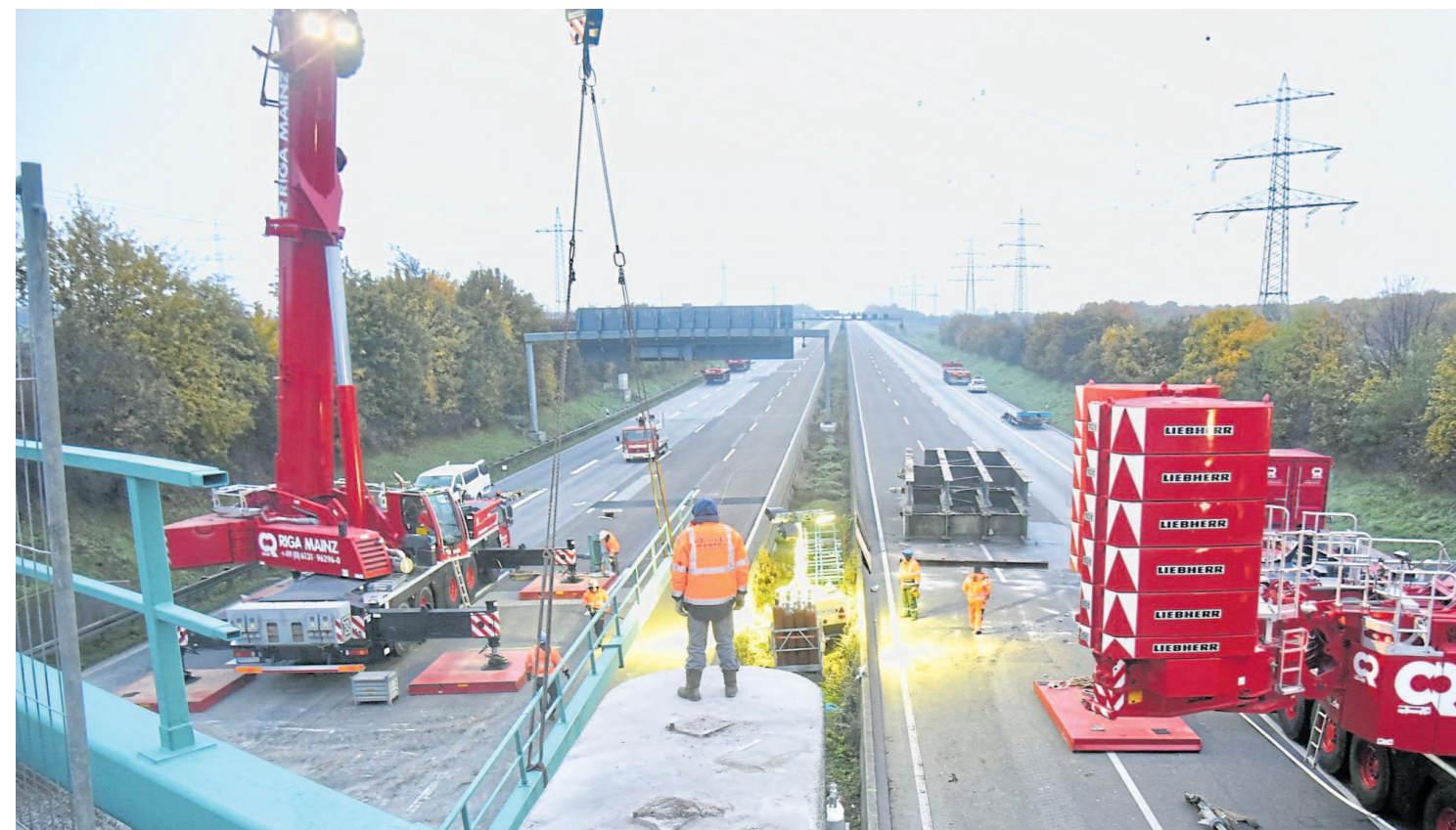
Die Brücke über die A5 wird Stück für Stück abgetragen.
